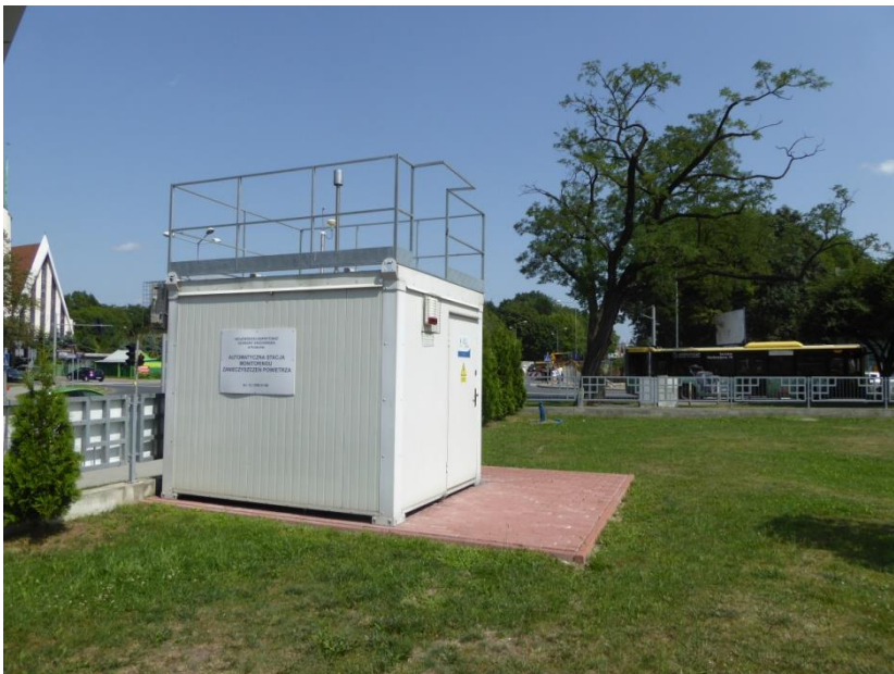
Fot.2. Stacja pomiarów zanieczyszczeń powietrza w Tarnobrzegu, ul. Ks. Romana Sitki
