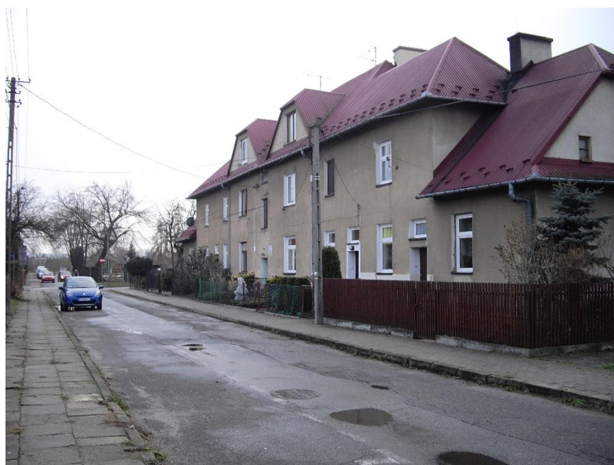
Rysunek 3 Przedogródek przy budynku mieszkalny wielorodzinnym ( źródło: własne )
