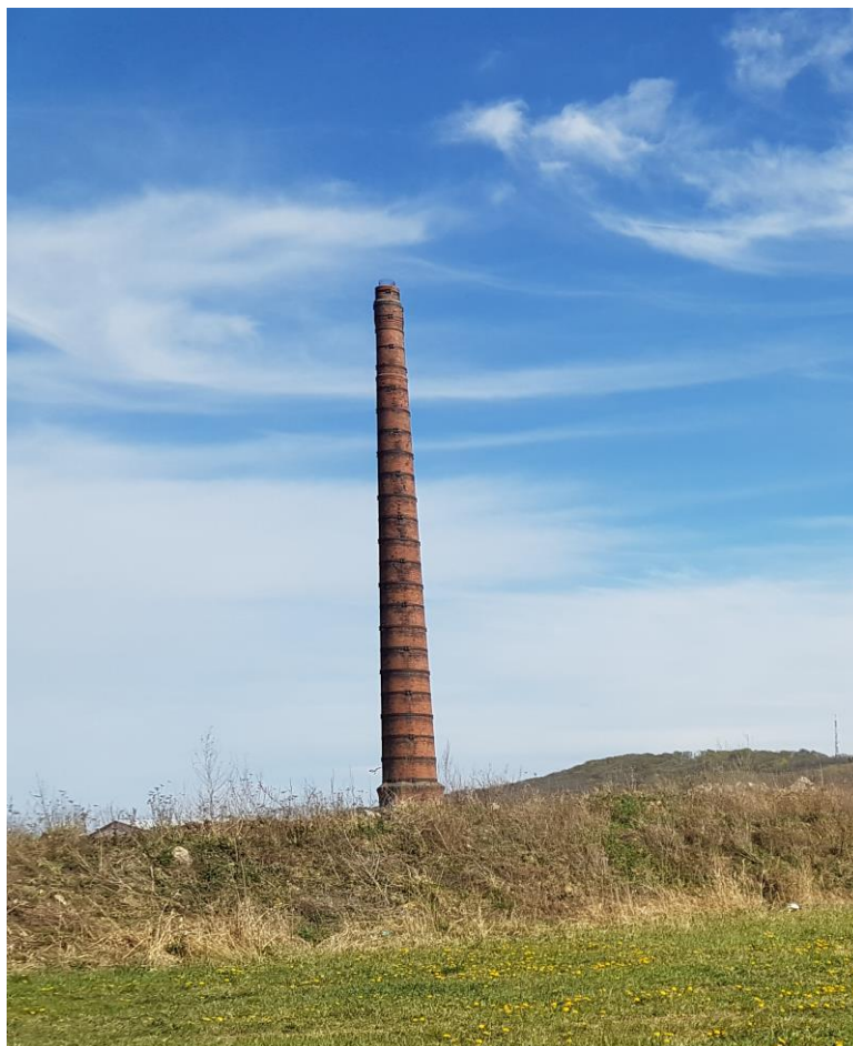
Zdjęcie 4 Komin z 1927 r. zlokalizowany na działce nr 25/49 obręb 0310 ujęty w gminnej ewidencji zabytków. (Źródło: zdjęcie własne autora)
