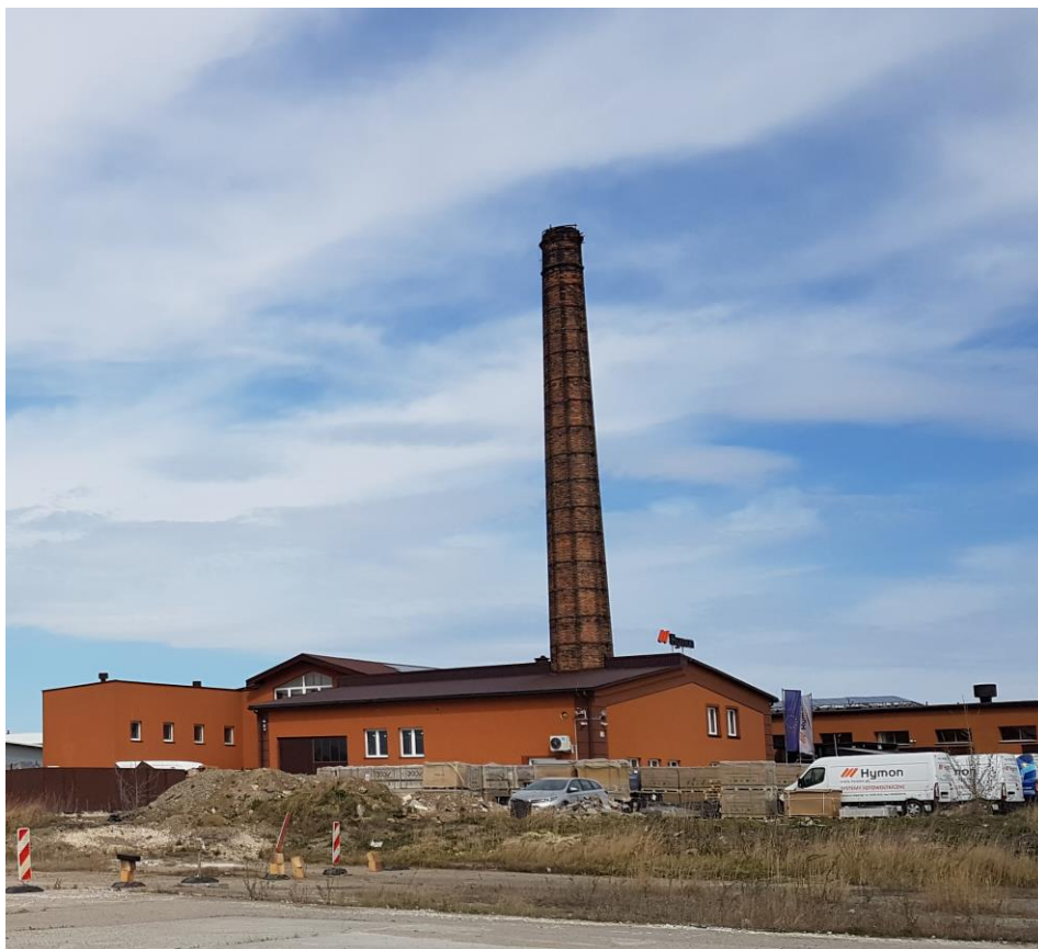
Zdjęcie 5 Komin zlokalizowany przy ul. Dojazd 16A ujęty w gminnej ewidencji zabytków (Źródło: zdjęcie własne autora)
