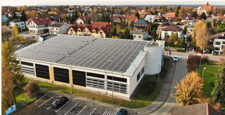
Zdjęcie 8: Instalacja fotowoltaiczna na krytej pływalni w Niepołomicach, zarządzanej przez spółkę Infrastruktura Niepołomice sp. z o.o. 24
